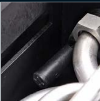
Flotteur pour le contrôle du niveau de l'eau dans la chaudière
