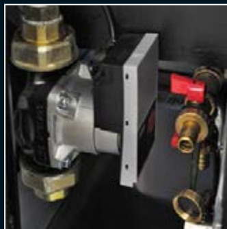
Circulateur pour circuit de chauffage intégré
